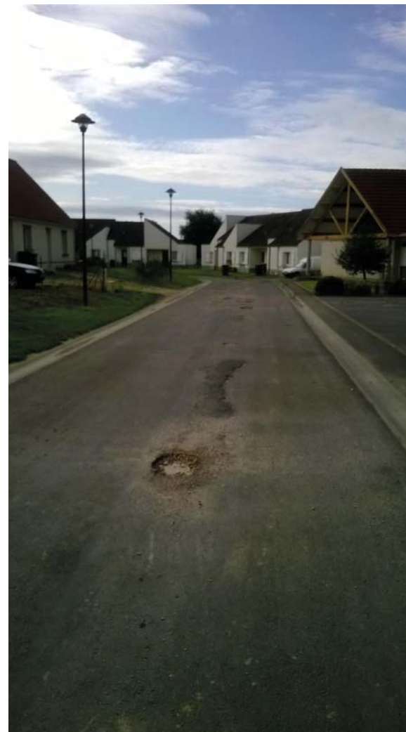
Refection de chaussée en enrobé à Hornoy-le-Bourg
